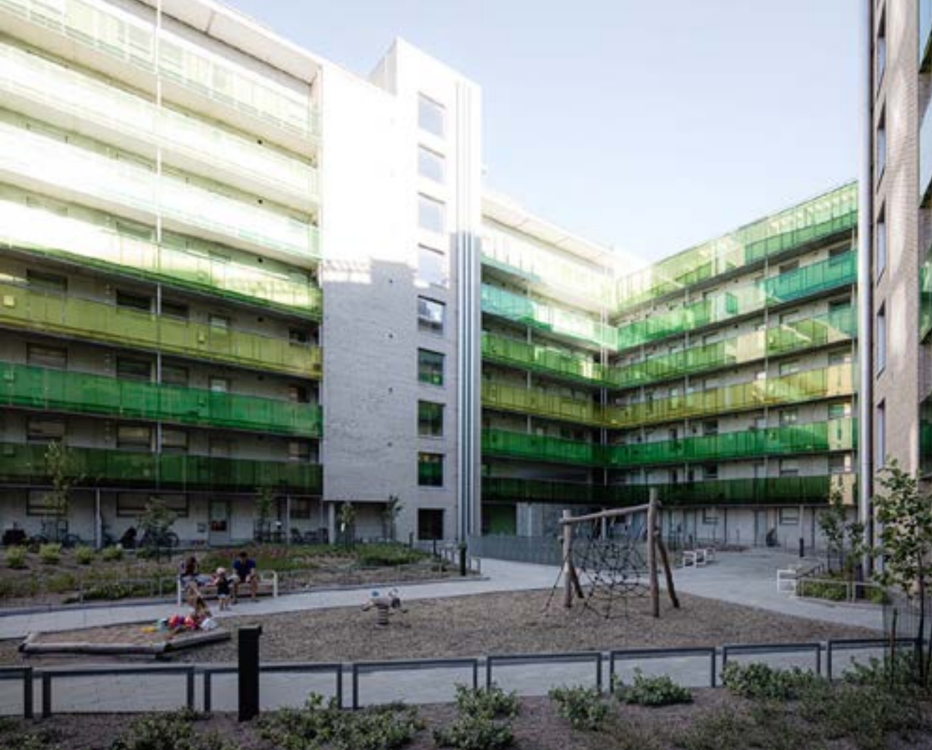
Pohled do dvora s patrným úsporným pavlačovým dispozičním uspořádáním nájemních bytů.
