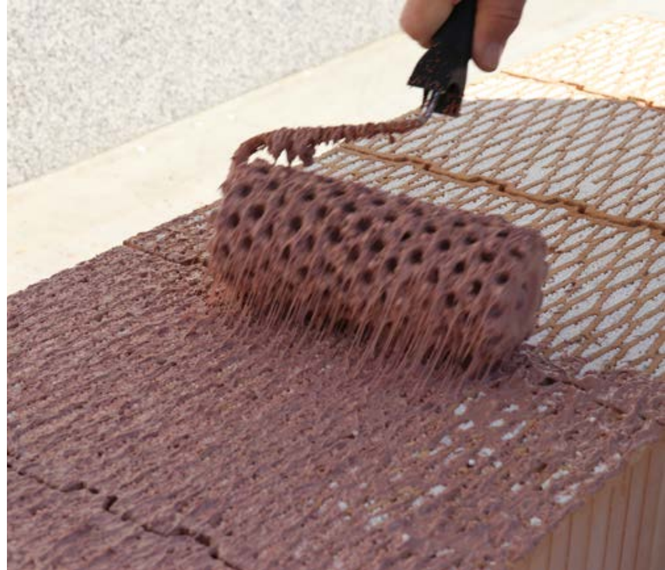
HELUZ SIDI – nanášení na obvodové zdivo HELUZ FAMILY 2in1
