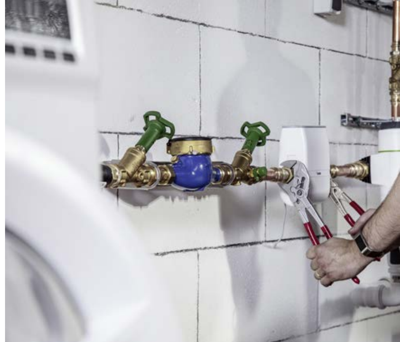
RE.GUARD se instaluje na hlavní přívod vody do objektu ihned za vodoměr
