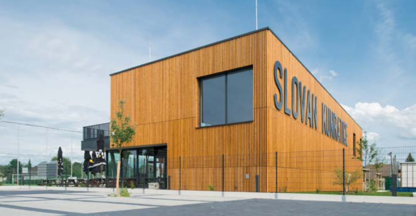
Původně měl vytápění a teplou vodu zajišťovat plynový kondenzační kotel, ten byl ale nahrazen dvěma tepelnými čerpadly vzduch–voda
