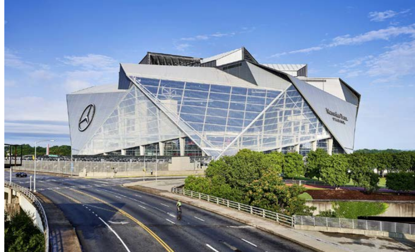
Šestnáctipatrová průhledná stěna – „okno do města“ – z plastové membrány ETFE je na severní a východní straně stadionu
