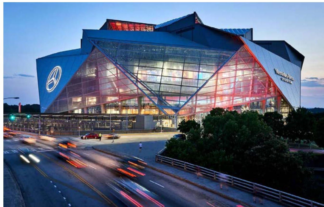
Lehká membrána snížila zatížení konstrukce stadionu
