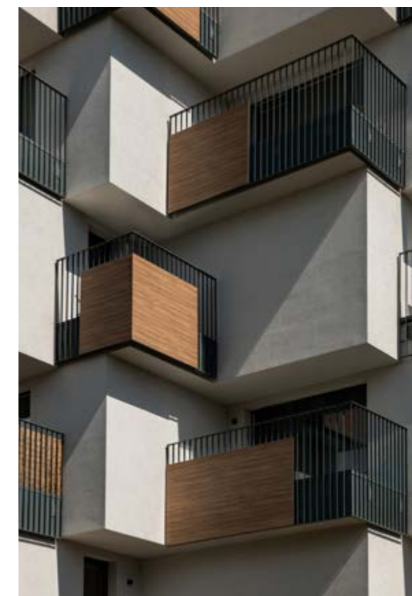
Rezidenční projekt Kaskády Hranice – detail
