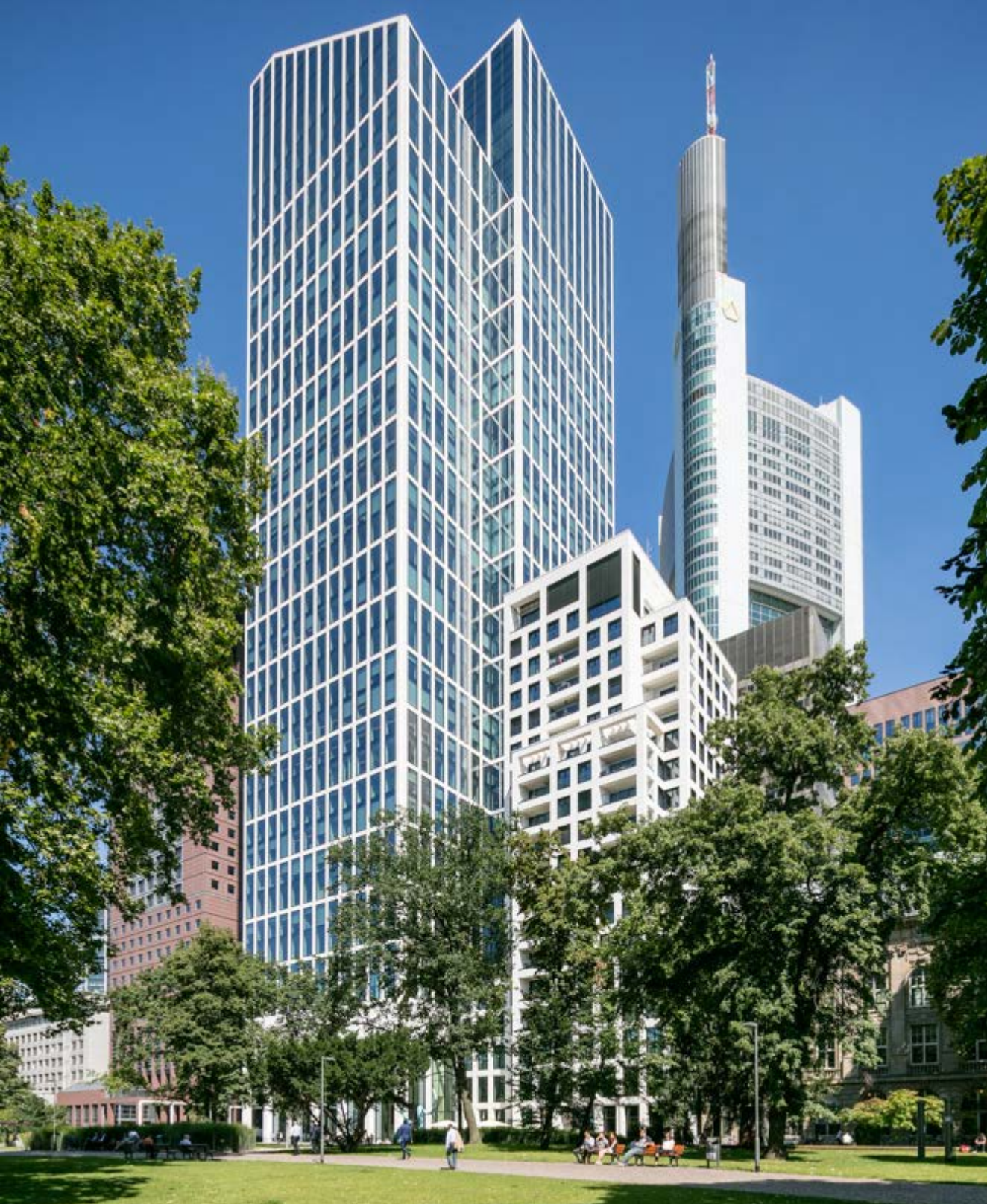
Budova využívá systémy zvlhčování vzduchu ORBIT WING®
