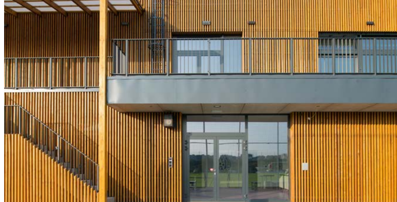
Fasádu tvoří modřínové latě doplněné o kovové oplechování
