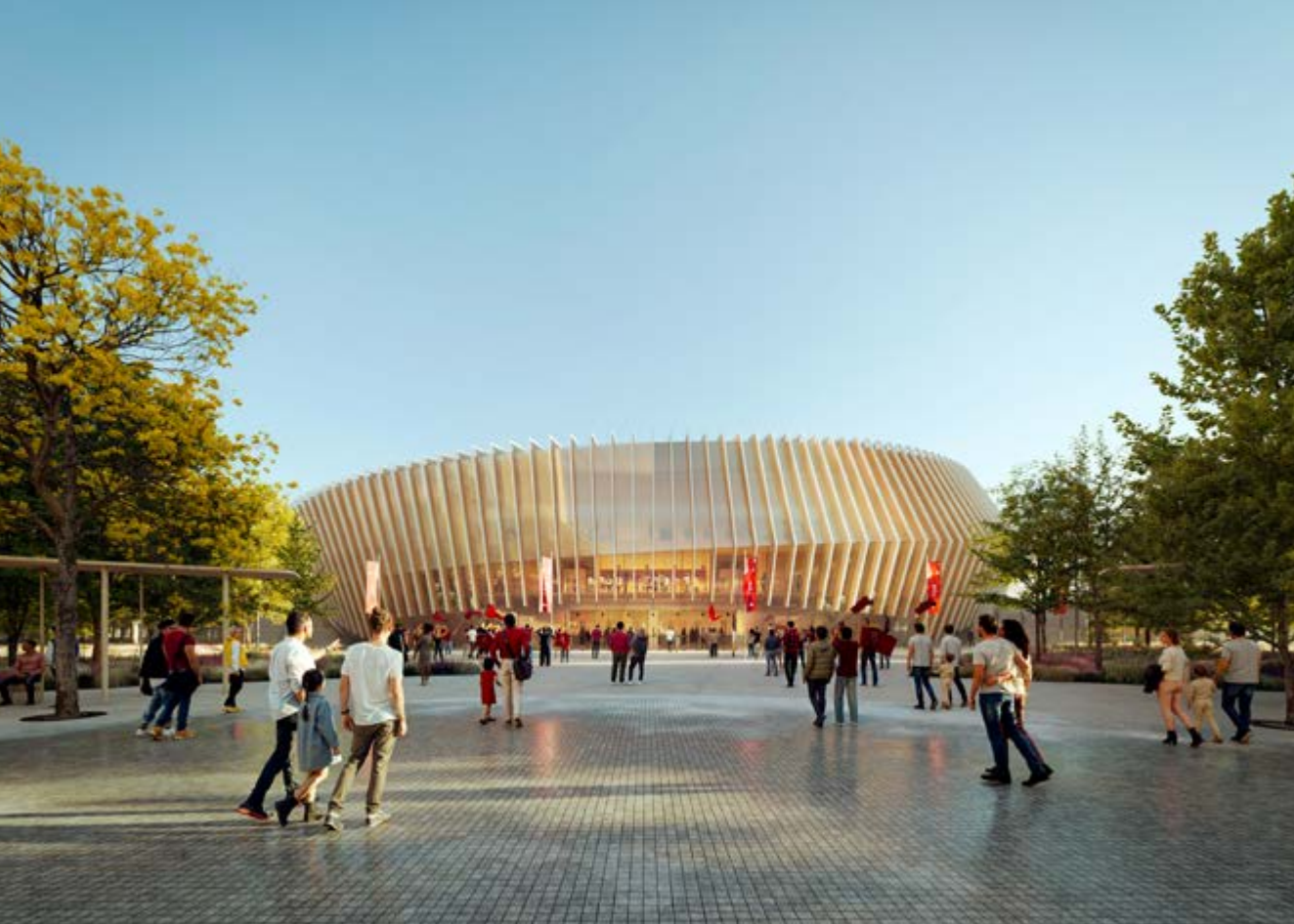
Fasáda využívá soudobých technologií, její stínění zajišťují šikmé lamely
