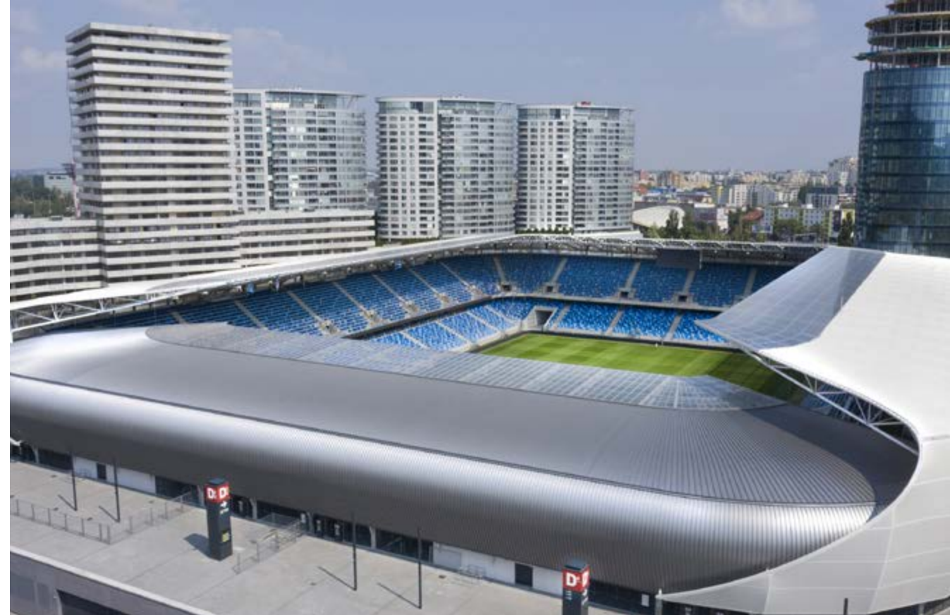
V přechodných obdobích je možné přebytečné teplo nebo chlad přenášet mezi různými částmi objektu
