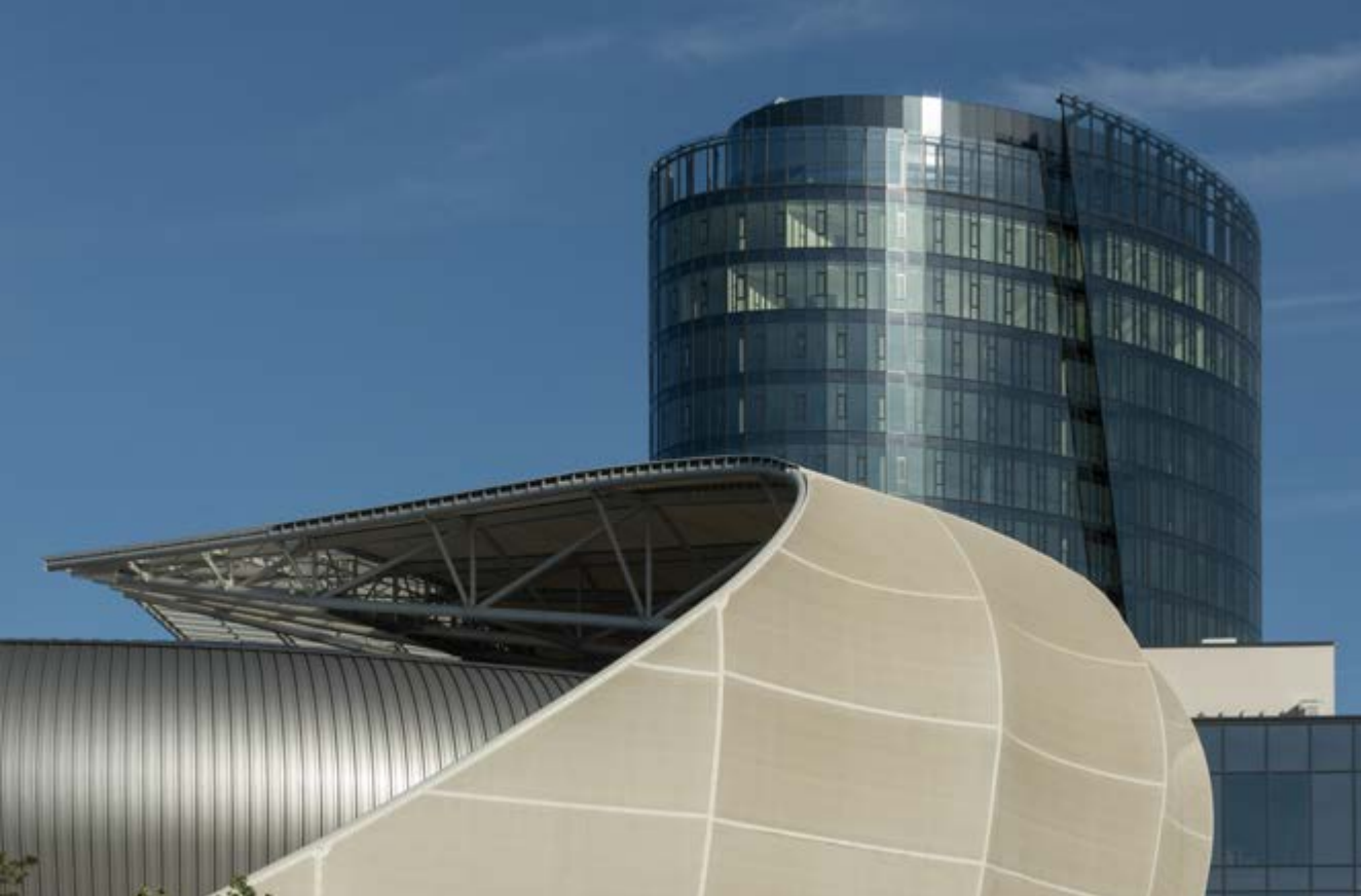
Hlavním zdrojem energie jsou tepelná čerpadla, která v roce 2023 zajistila 77,96 % chladu a tepla stadionu
