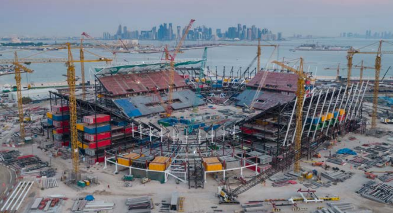
Z výstavby – do rastrové konstrukce byly vkládány jednotlivé komponenty – barevné kontejnery
