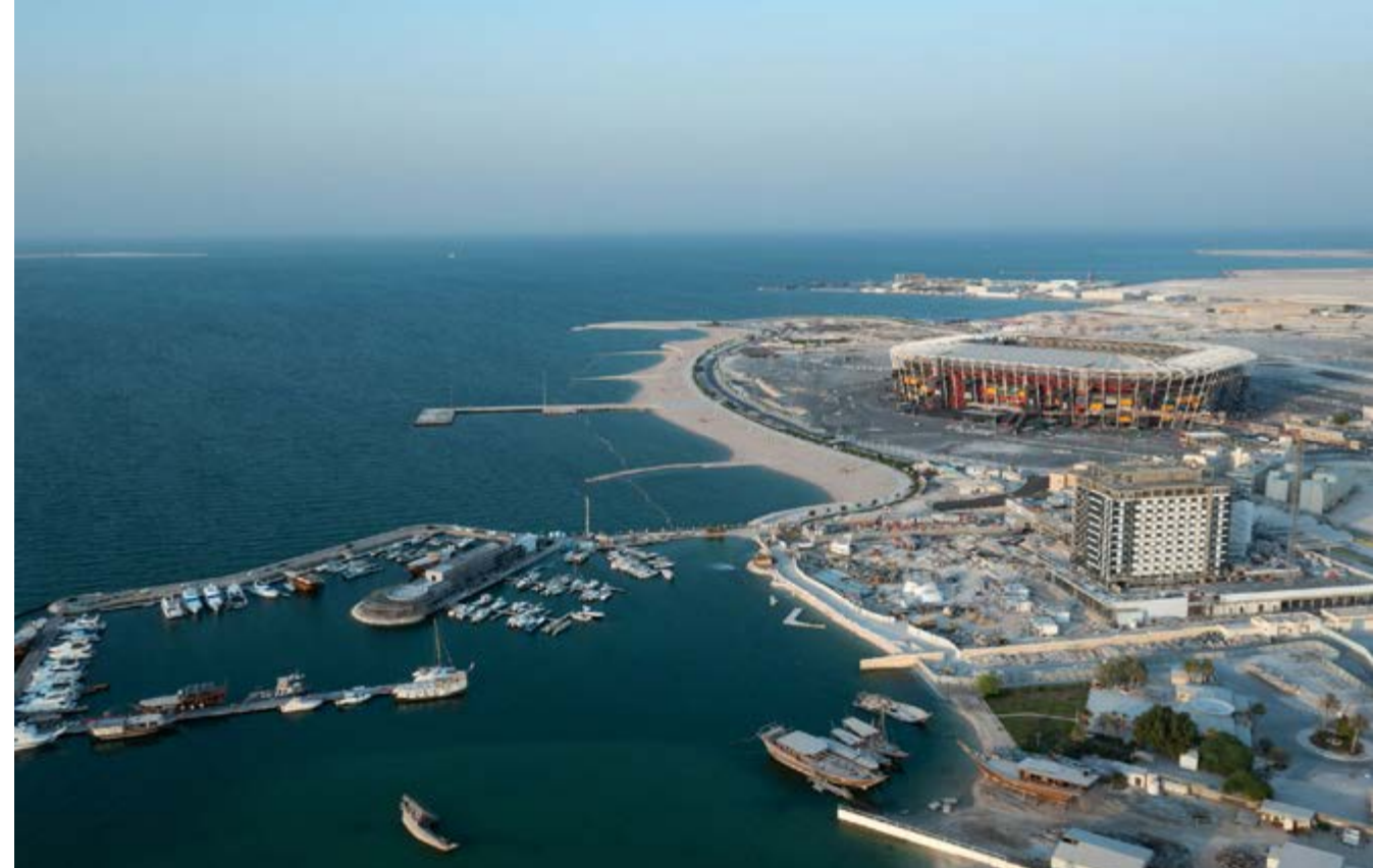
Kontejnery bylo možné přepravovat přímo na staveniště po moři, navíc byly odkazem na historii lokality, která se nachází v těsné blízkosti přístavu
