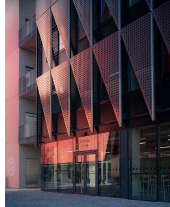
Detail perforované hliníkové fasády
