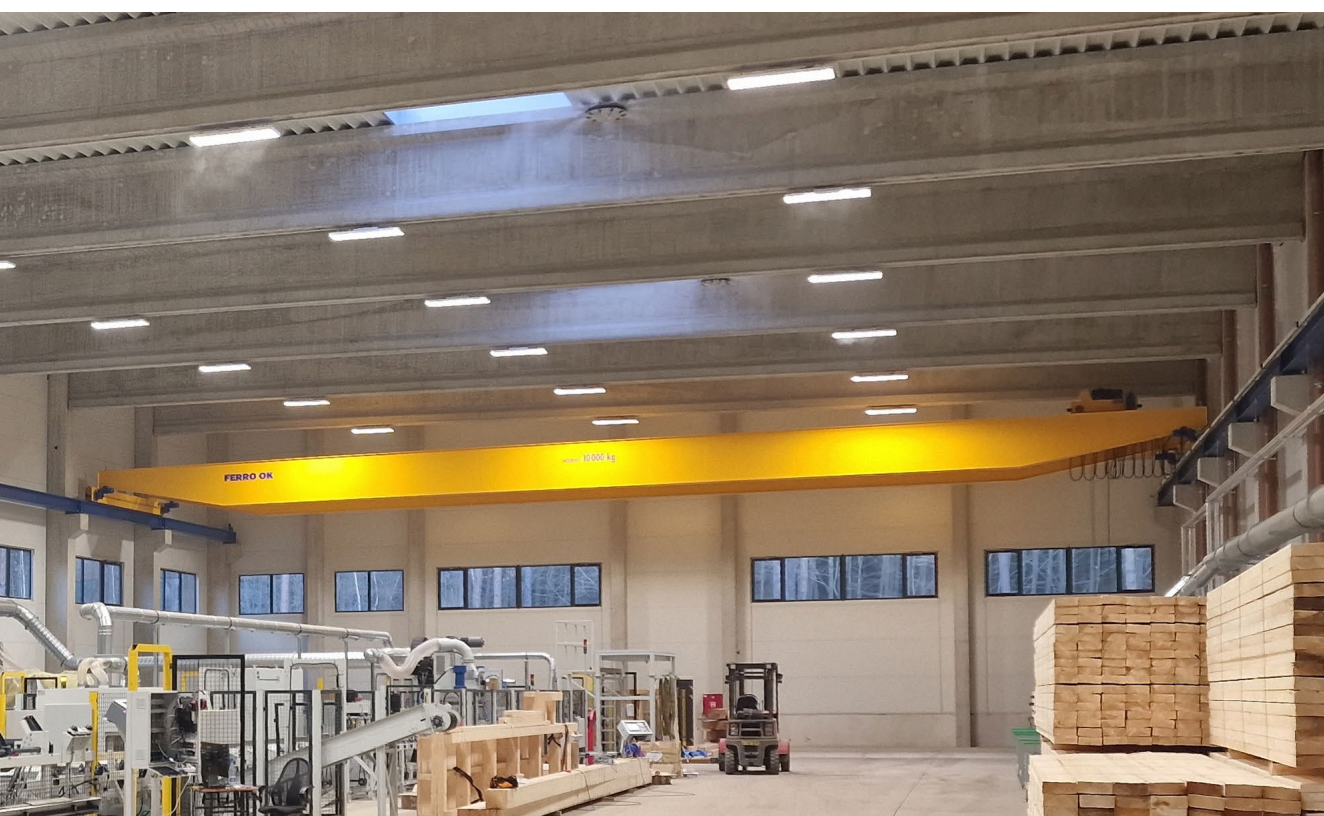
Destratifikátory Merlin Technology, zde v dřevařském provozu, umožňují kontinuální promíchávání vzduchu
