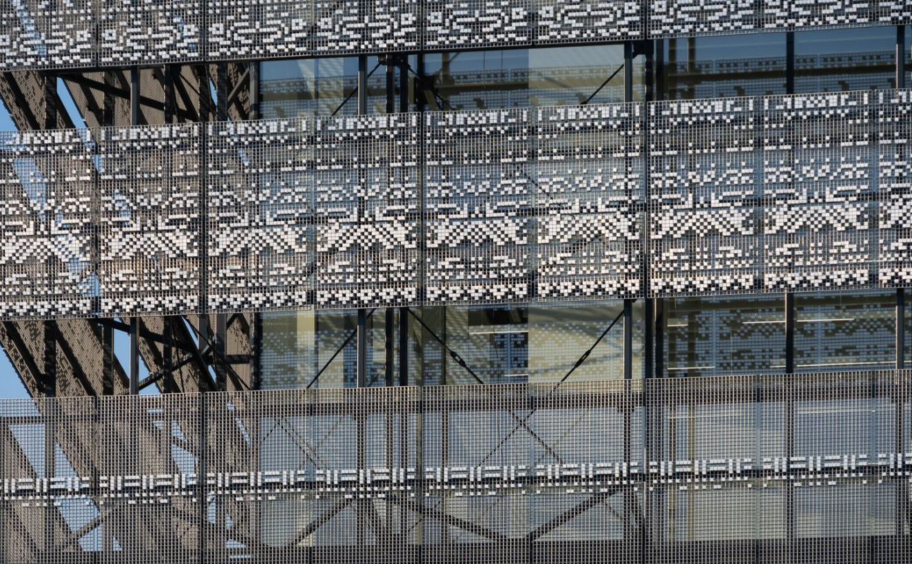
Vygenerovaný vzor osmipásové pixelované fasády s 2 000 hliníkovými mřížkami
