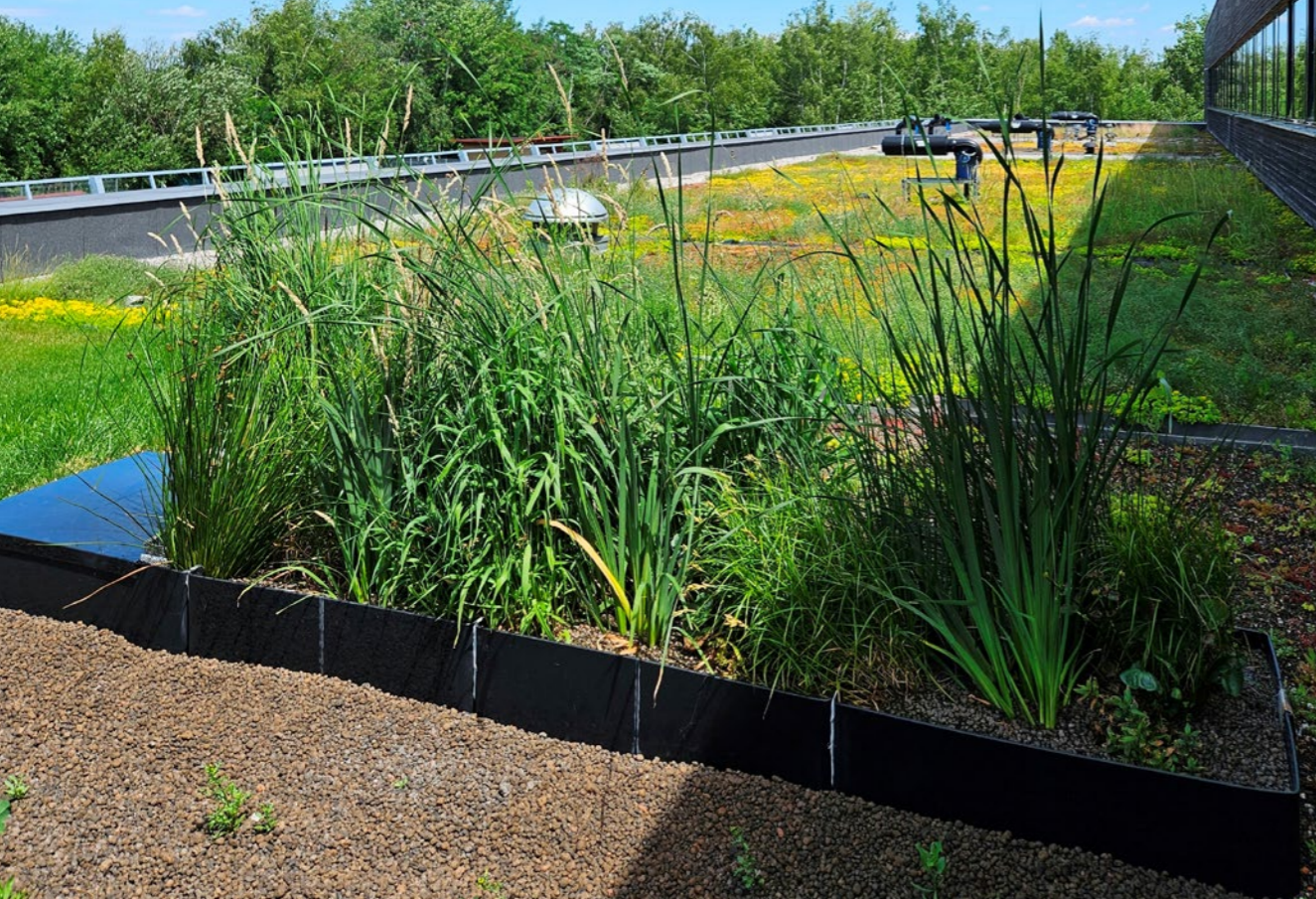
Na střeše ČVUT UCEEB jsou testovány tři různé skladby zelené střechy na stejné vrstvě minerální vaty o tloušťce 50 mm
