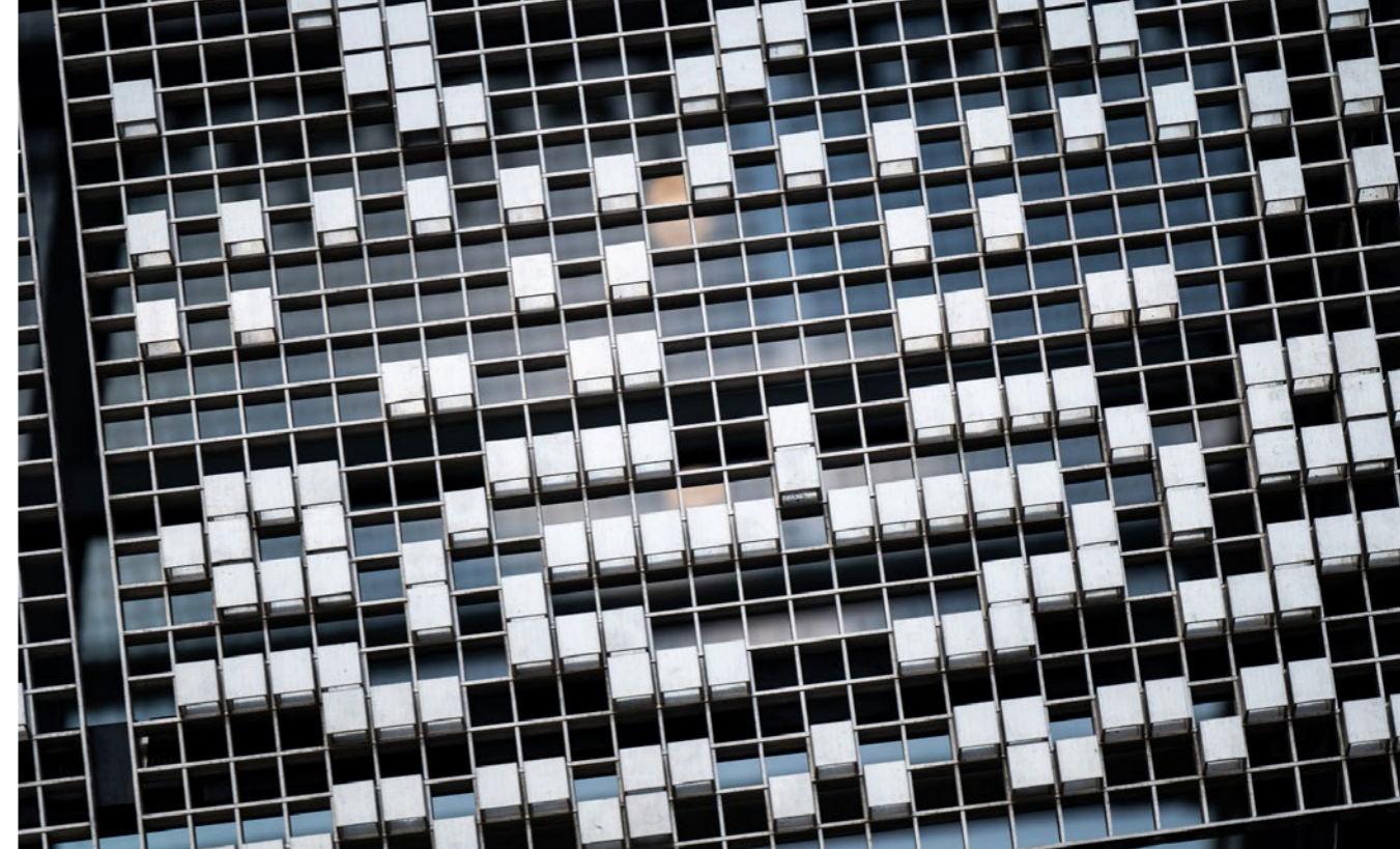
Detail fasády – kostičky byly do mřížek umístěny pomocí speciálního robota
