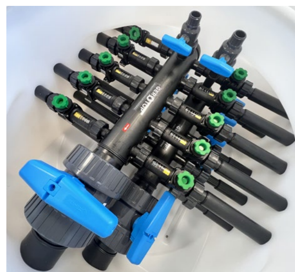
Svedení deseti vrtů v jímce a napojení na páteřní vedení do domu
