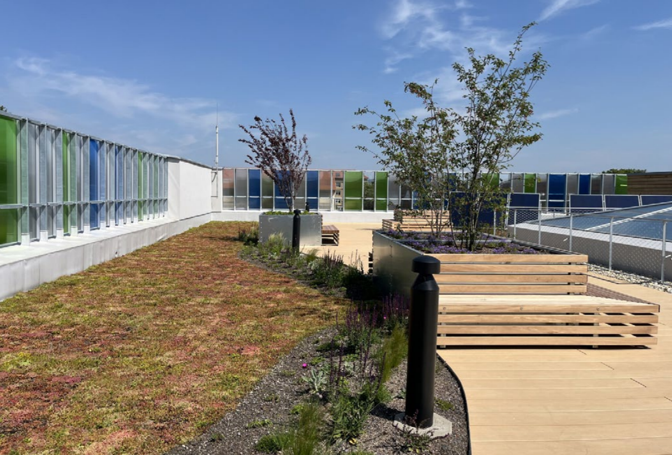
Střešní zahrada je složena z dřevěné terasy a vegetační plochy
