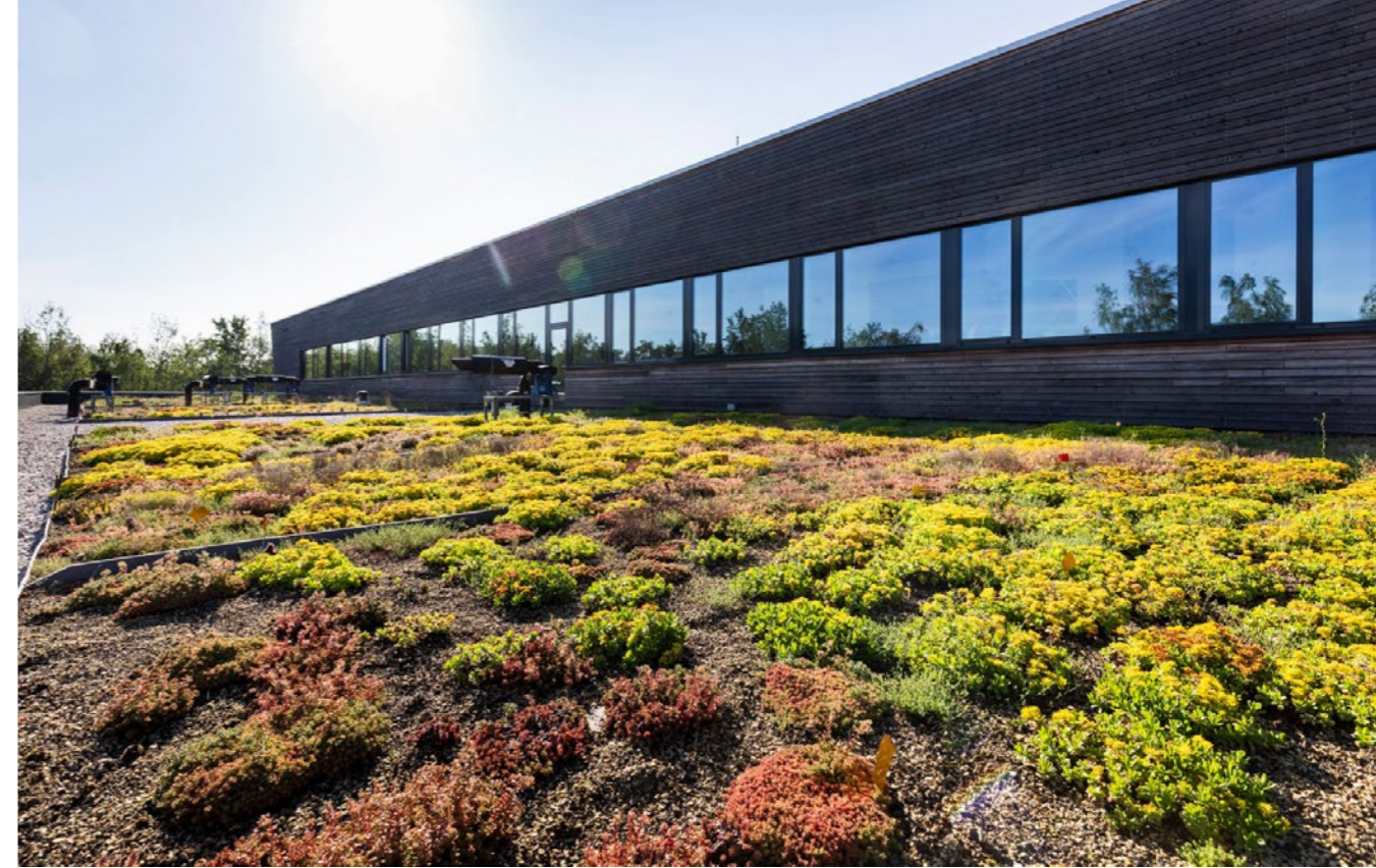
Vedle své výzkumné funkce zelená střecha poskytuje příjemný výhled z oken přilehlého open space a administrativní části budovy
