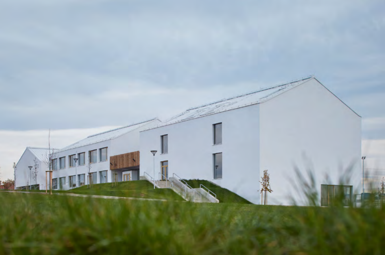
Základní škola pro 450 dětí je vytápěna kaskádou tepelných čerpadel a soustavou kondenzačních plynových kotlů. Foto: BoysPlayNice
