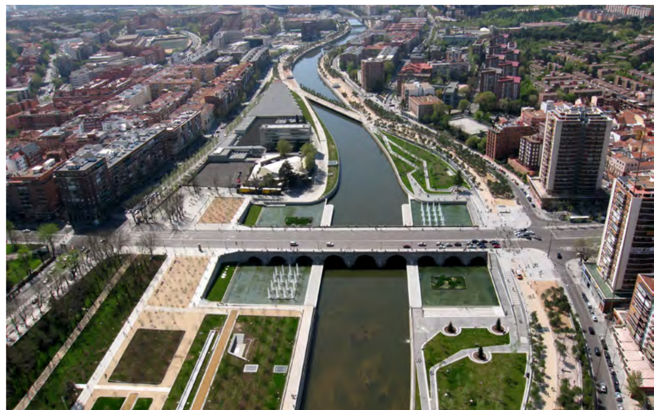
Madrid Río, Madrid, Španělsko. Autoři: Burgos & Garrido / Porras La Casta / Rubio & Álvarez-Sala / West 8. Realizace 2011. Vítězové mezinárodní architektonické soutěže navrhli v roce 2005 rekultivaci části dálničního okruhu výhradně prostřednictvím krajinářské architektury. Původní stav a současnost. Foto archiv Burgos & Garrido Arquitectos
