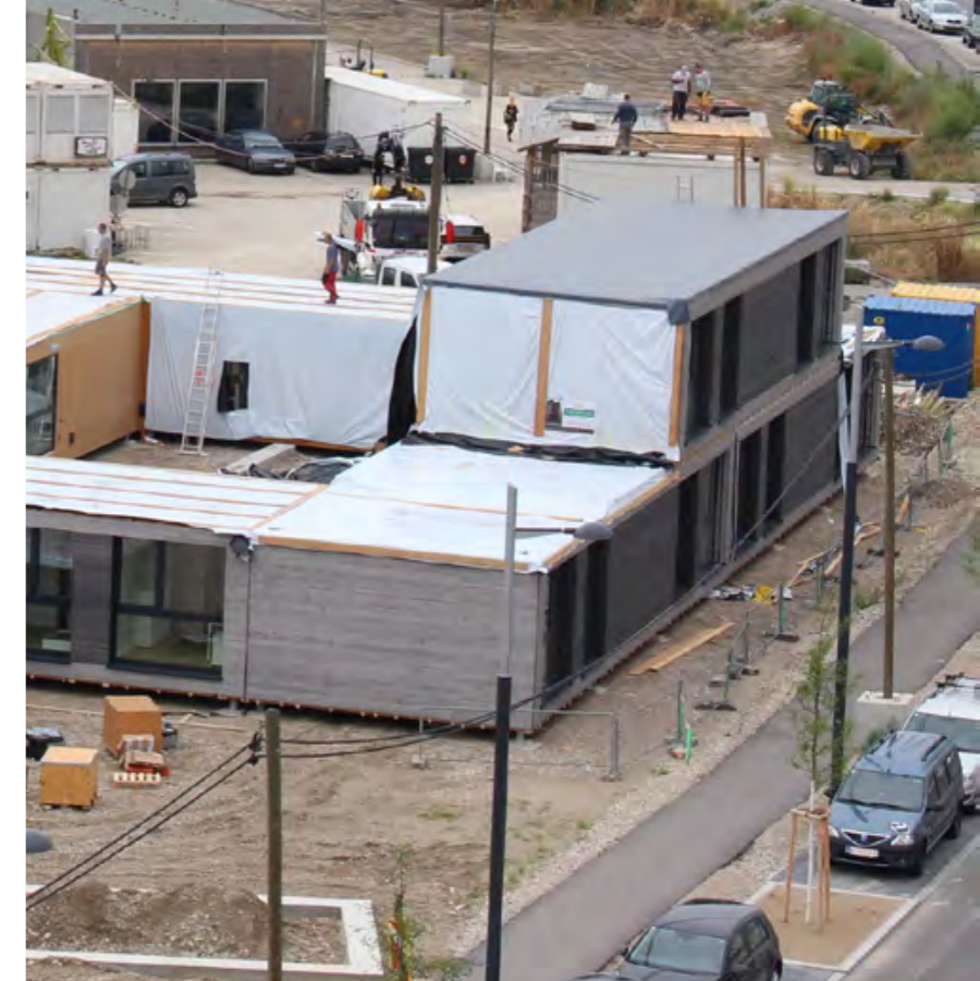
Deset prefabrikovaných modulů o rozměrech 5,5 x 16,8 m bylo dopraveno na místo, uloženo a smontováno během jednoho týdne.
