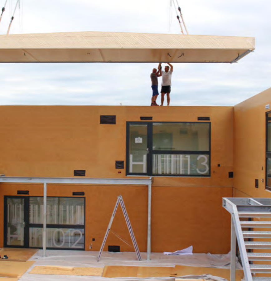
Deset prefabrikovaných modulů o rozměrech 5,5 x 16,8 m bylo dopraveno na místo, uloženo a smontováno během jednoho týdne.
