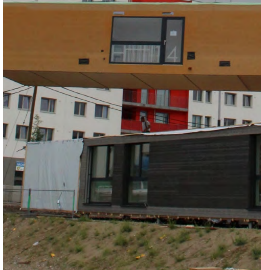
Deset prefabrikovaných modulů o rozměrech 5,5 x 16,8 m bylo dopraveno na místo, uloženo a smontováno během jednoho týdne.
