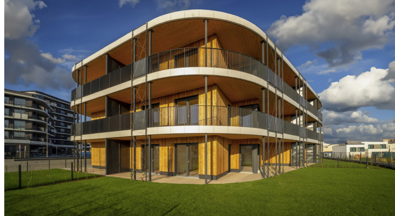
CLT panely byly použity také na nosné vnitřní stěny, stropy a balkony. Je z nich realizována rovněž výtahová šachta (první tohoto druhu u nás). Výjimku tvoří budova J, která má z požárních důvodů celé schodiště a výtahovou šachtu z betonu.
