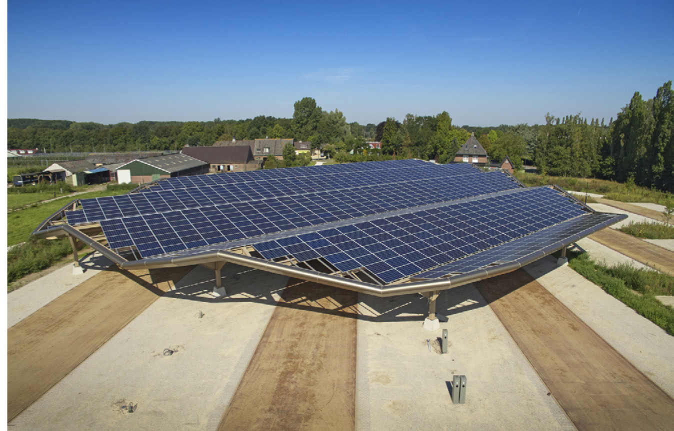
Parkovací stání mají na střeše 3 300 m 2 solárních panelů
