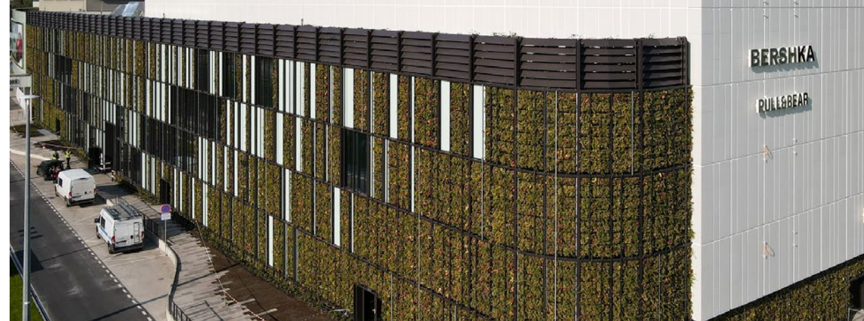
Hydroponická fasáda BioTile na nové přístavbě bratislavského nákupního centra Aupark je největší zelenou fasádou ve střední Evropě: 690 m 2 , výška 18 m, délka 130 m. (Projekt: studio jaar)
