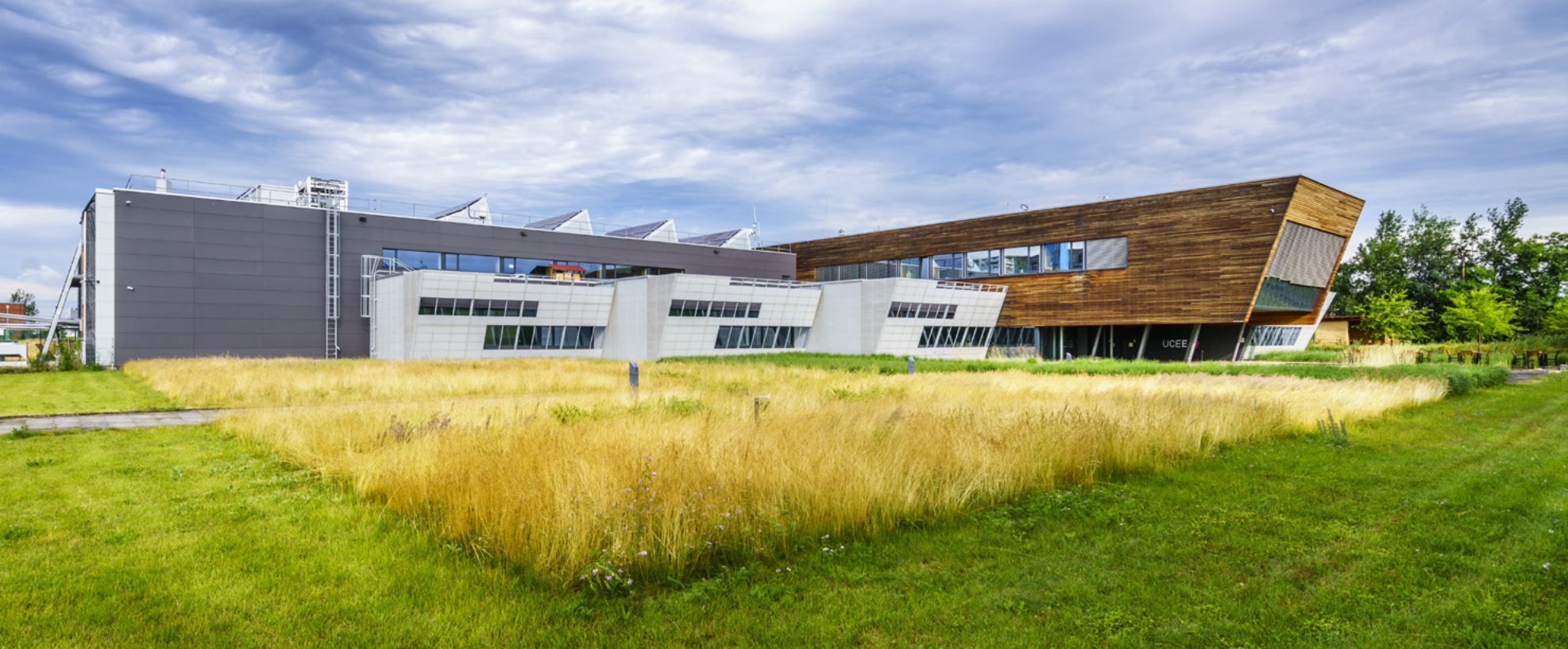
Dominantu UCEED tvoří administrativní křídlo, položené na střeše laboratoří ve směru západ – východ jako dřevěný hranol se šikmo seříznutými čely
