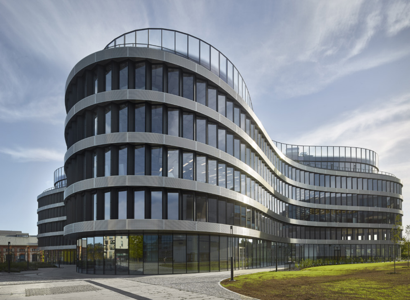
Vnější fasáda je tvořena tzv. „zuby“, které jsou realizovány jako samostatné na sebe navazující elementy vycházející z rámové okenní konstrukce
