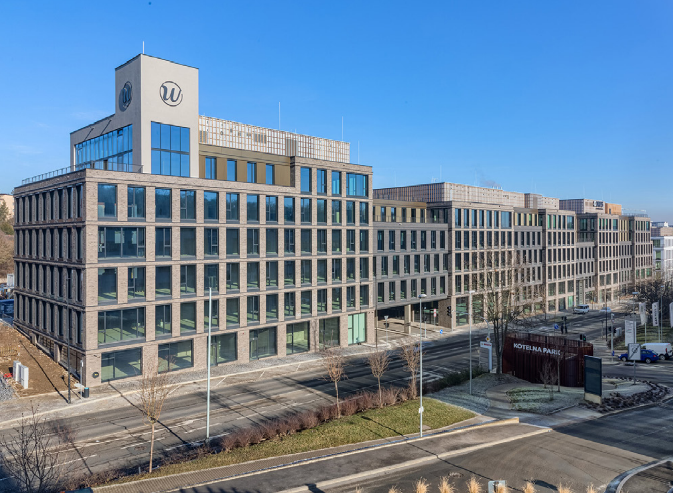
Metalica je první fasádou v ČR, která využila technologii Brickology – kombinaci tradiční cihlové fasády a odvětrávané fasády
