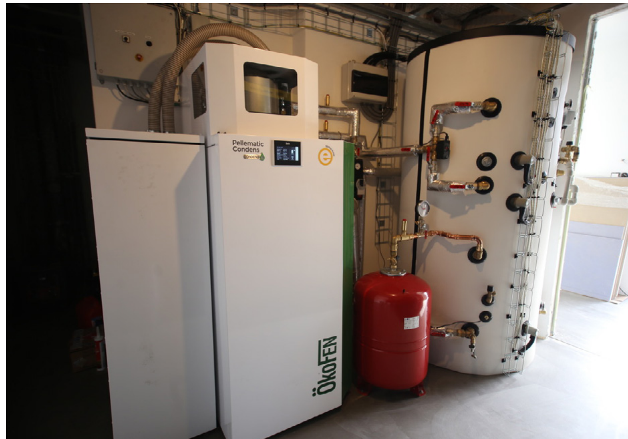
Kotel se Stirlingovým motorem
