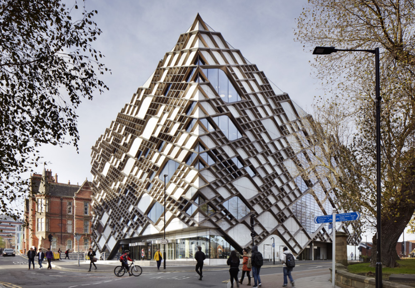
Obvodový plášť budovy Twelve Diamond v Sheffieldu je složen z osmi set prosklených elementů – do hliníkových profilů vložila společnost SIPRAL skla společnosti HELUZ IZOS
