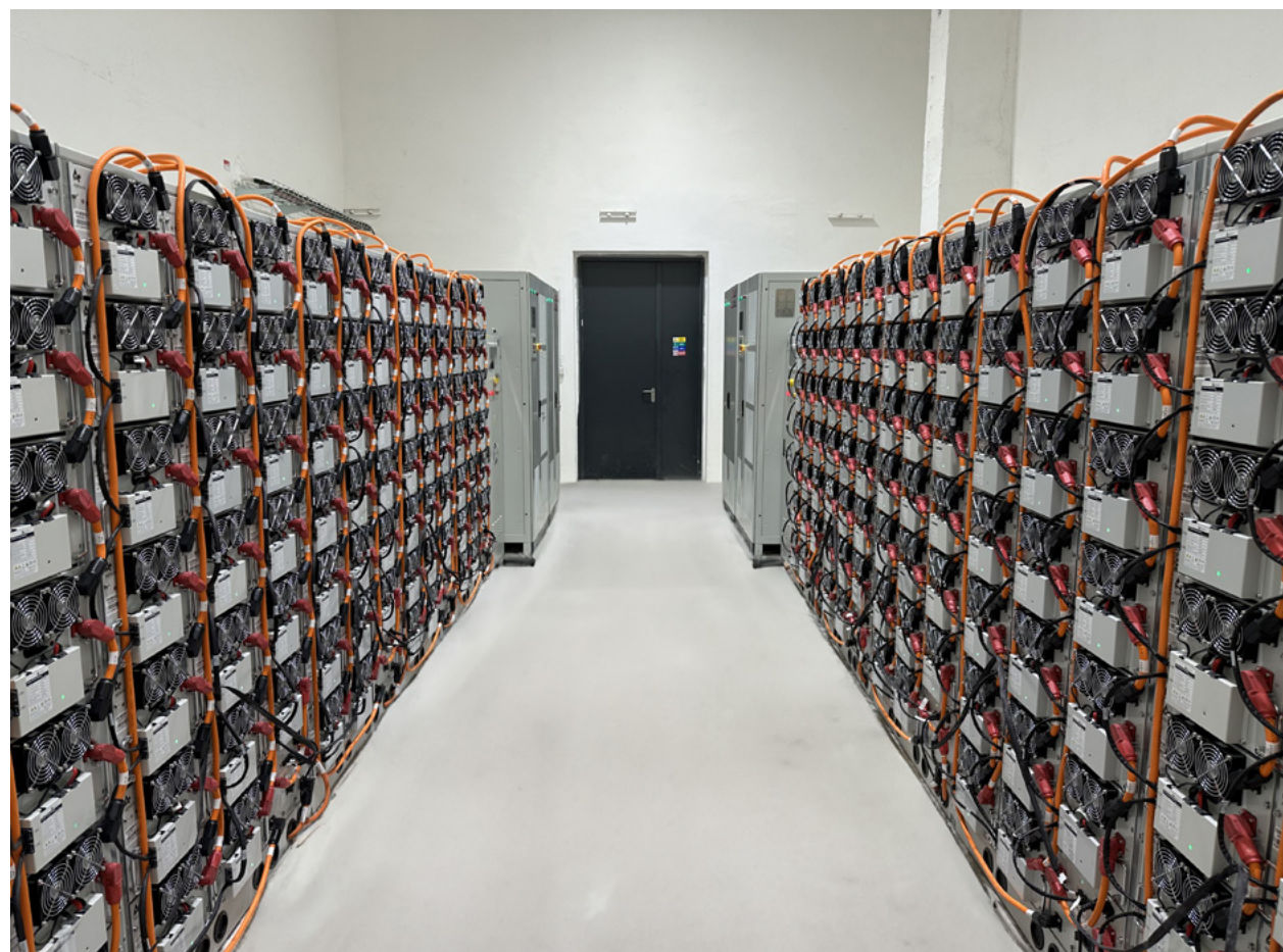
Úložiště se nachází v místnosti s odvětráváním a je chlazeno klimatizačními jednotkami, které zajišťují stálou teplotu 27 °C. Součástí systému jsou čidla, která zajišťují regulaci chlazení.
