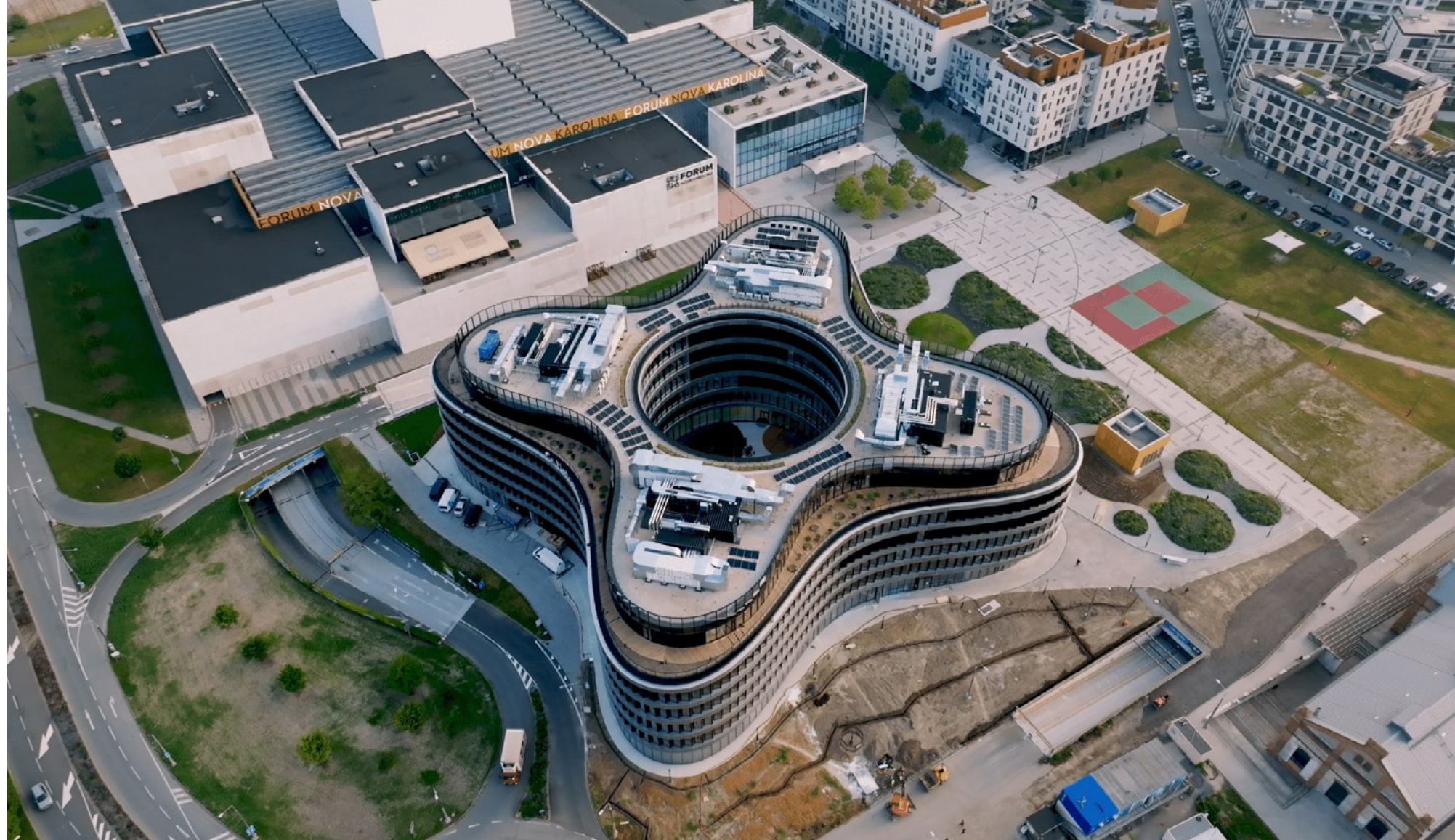
Půdorys se stranou o délce 85 m má tvar vrtule, která má odkazovat na průmyslovou minulost regionu. Hrubá podlažní plocha (HPP) podzemní části budovy činí 14 612 m 2 , HPP nadzemní části 26 327 m 2
