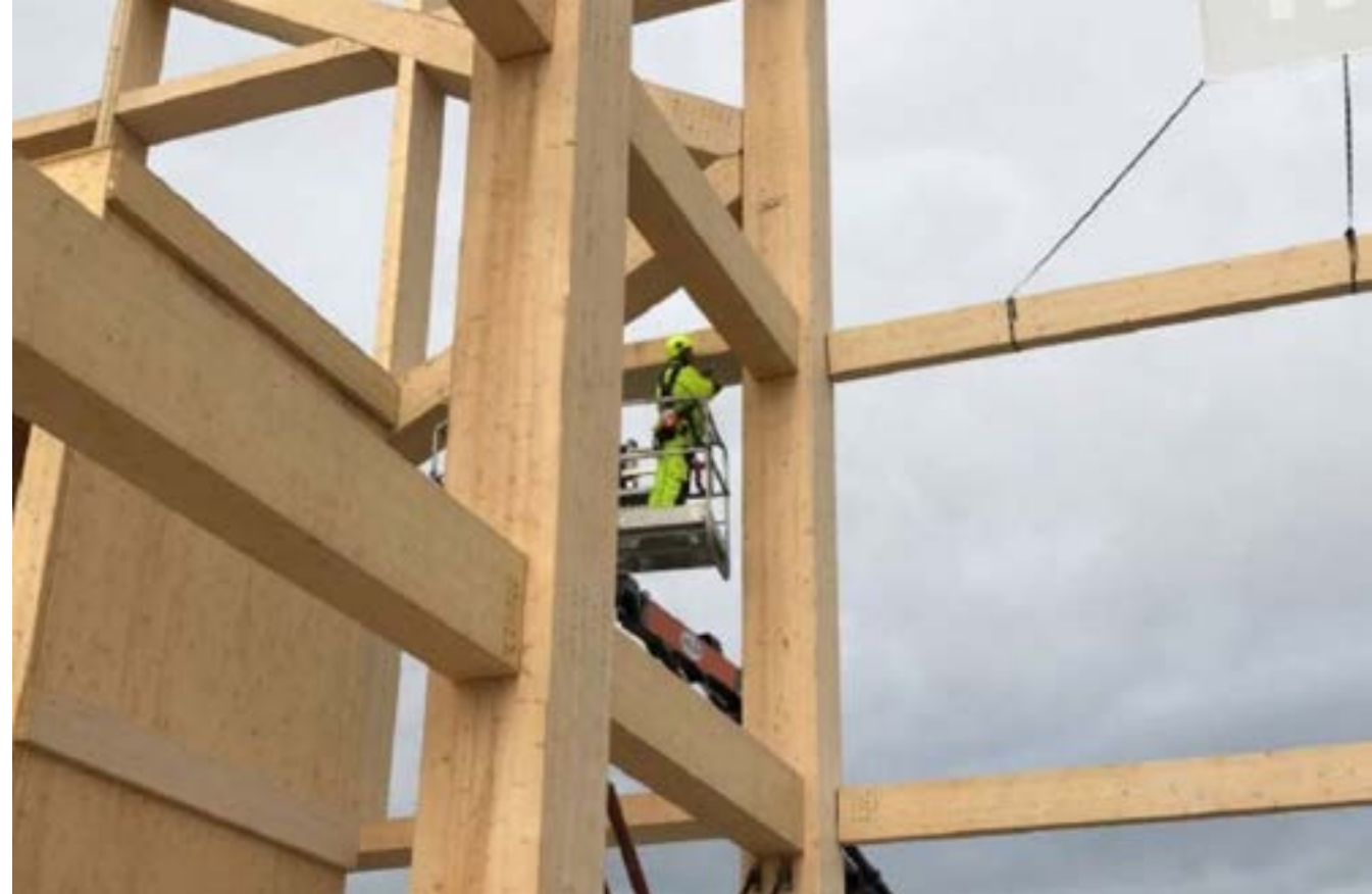
Výstavba těžkého skeletu dřevostavby s diagonálním ztužením.
