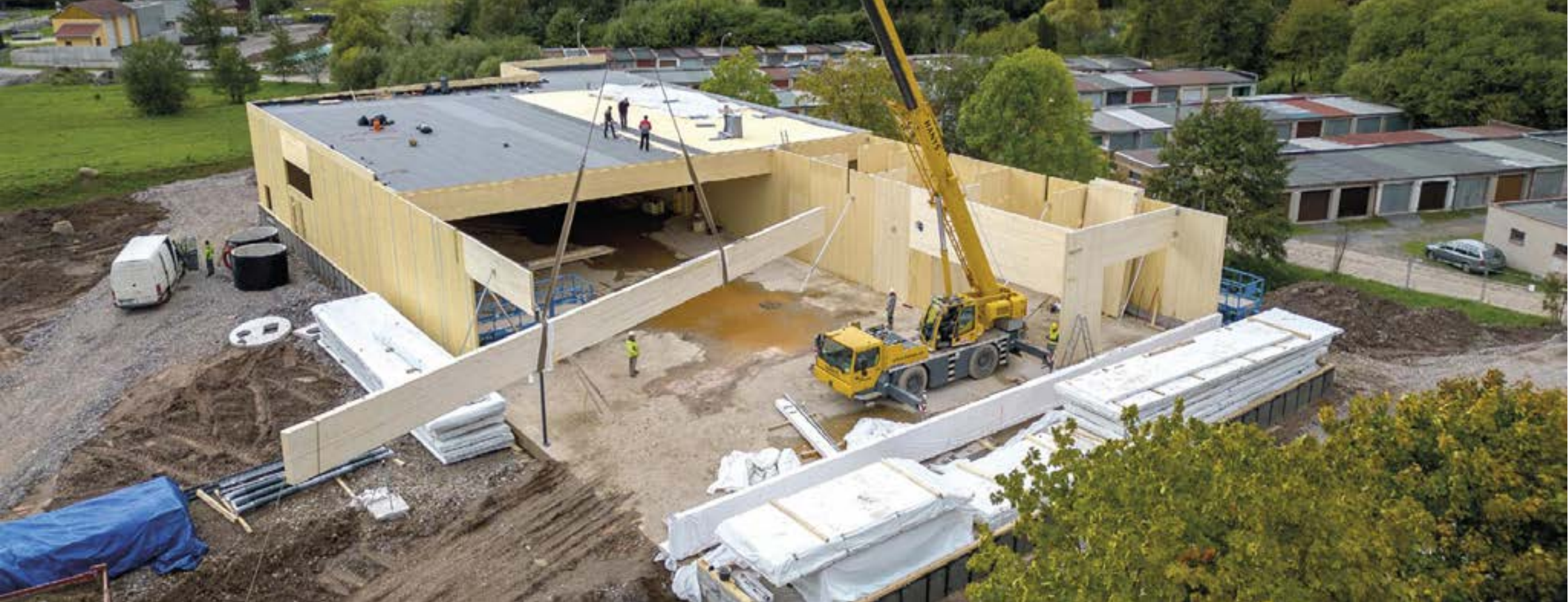
Na konstrukci obchodu bylo využito křížem lepené dřevo a lepené lamelové dřevo.
