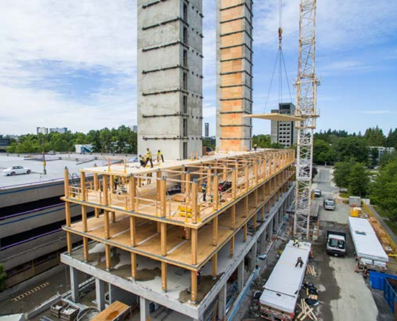
Výstavba dřevostavby s betonovými výztužnými jádry.
