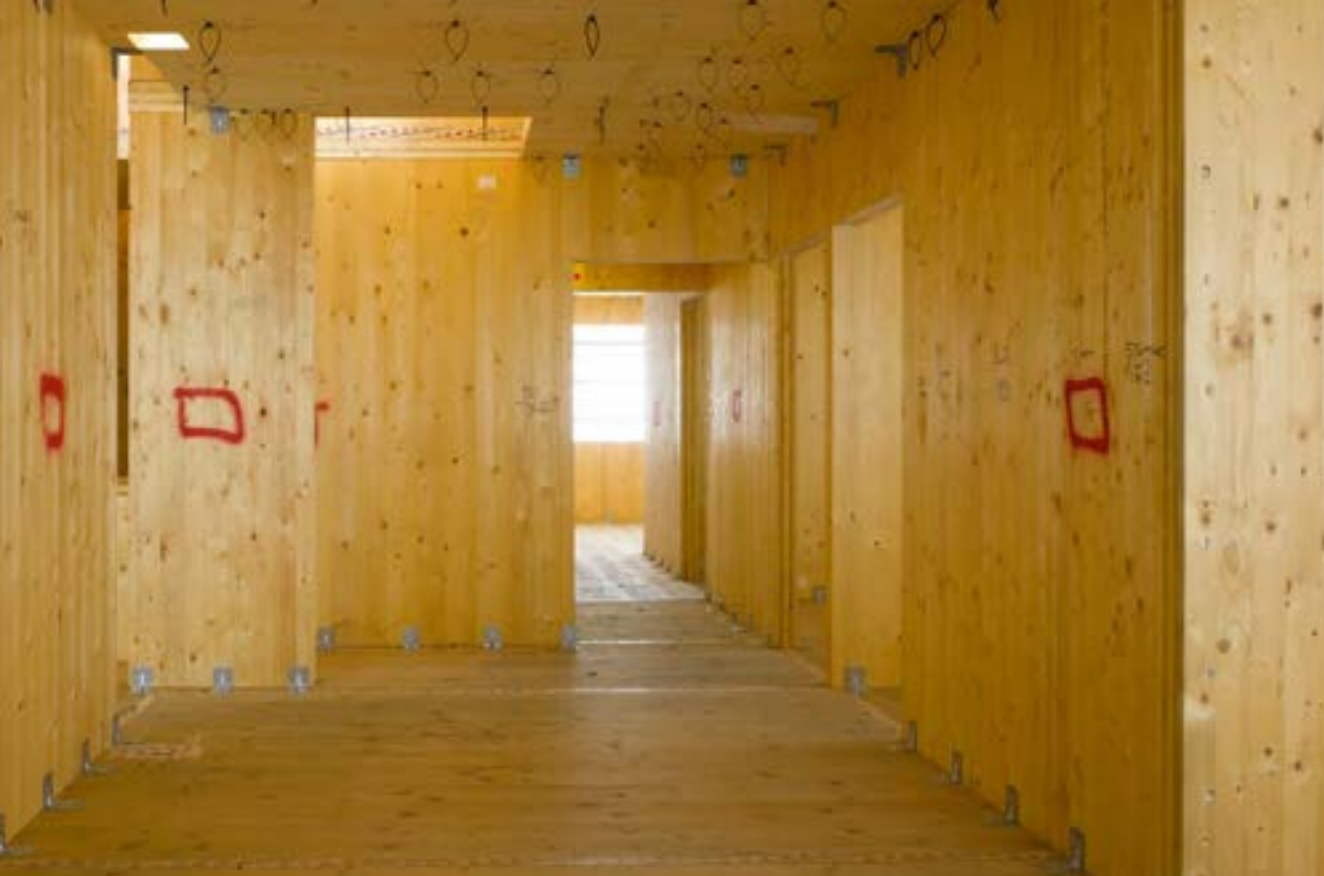
Dřevostavba s výztužnými a nosnými stěnami z CLT panelů.
