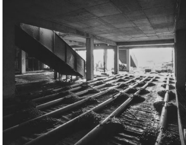
Zemní výměník tepla ve výstavbě, asi 1986.
