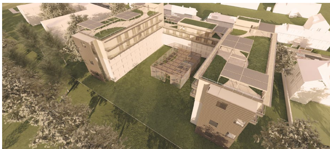
Pohled shora na koleje Větrník s navrženou nástavbou, vizualizace. Fotovoltaické panely jsou integrovány do stínících pergol na pobytové vegetační střeše.
