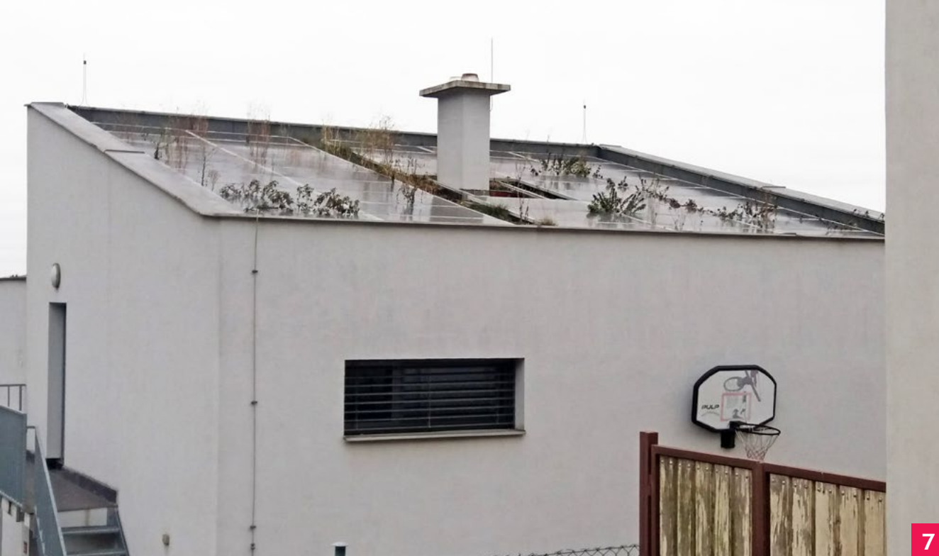
Nefunkční kombinace zelené střechy a fotovoltaiky na RD v Praze. Fotovoltaika byla realizována dodatečně přes veškerou zeleň, údržba neprobíhá ani nemůže. (Foto: GreenVille)
