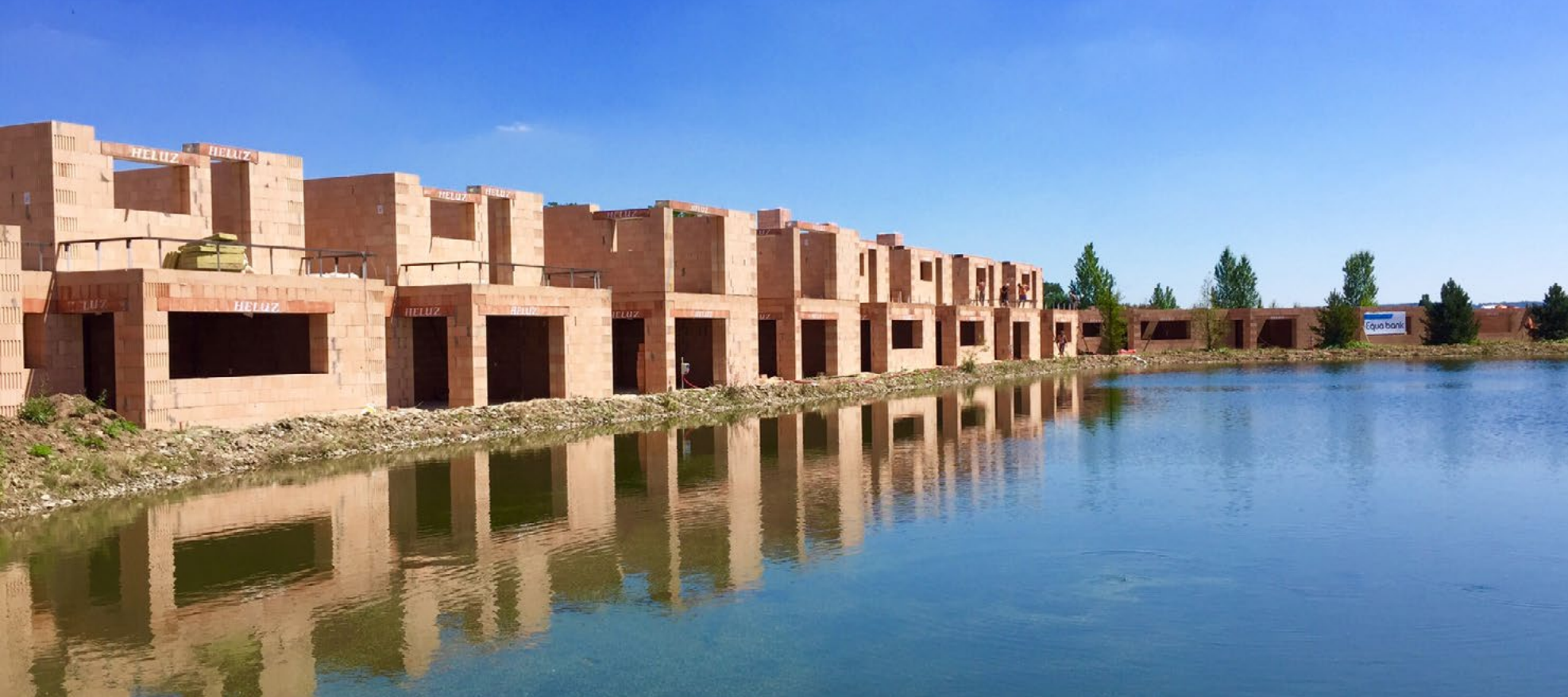
Jednovrstvá konstrukce – cihly zajišťují jak nosnou tak tepelně izolační funkci.
