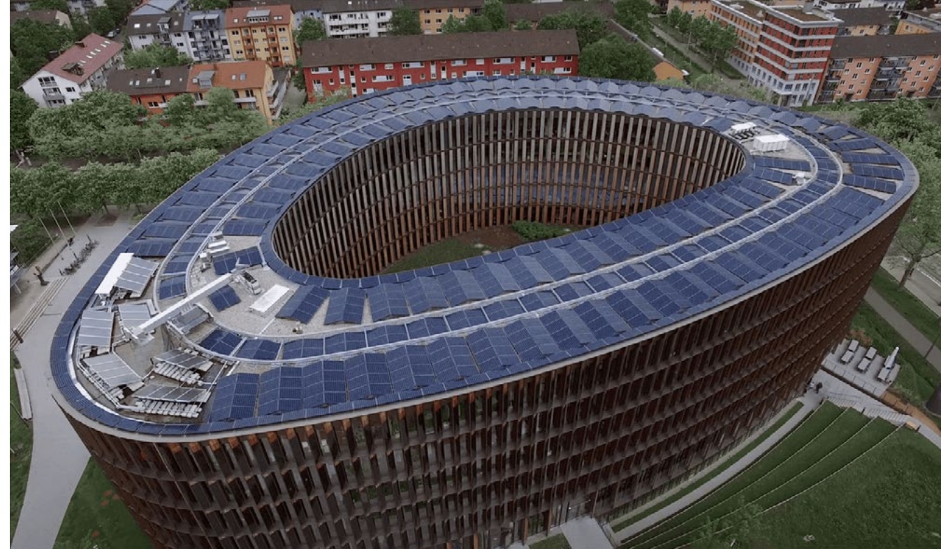
Fotovoltaicko-termické solární kolektory na střeše a fotovoltaický systém na fasádě pokrývají celkem 13 000 m 2 .
