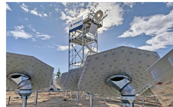
Heliostat je ukotvený na konstrukci z předpjatého betonu a ocelové trubce.
