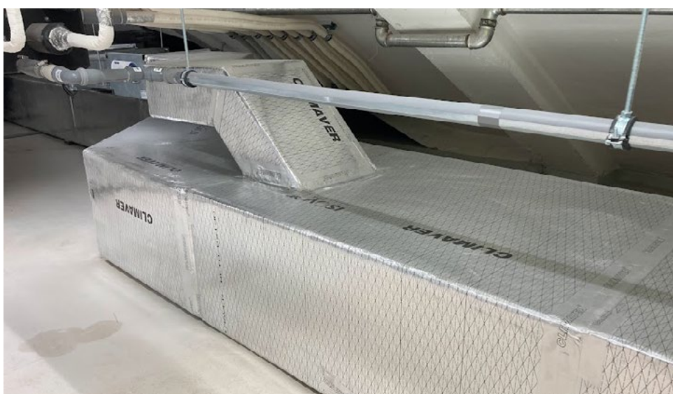
Nízká hmotnost ulehčuje práci nejen při výrobě potrubí, ale také při instalaci potrubí ve stísněných prostorách.
