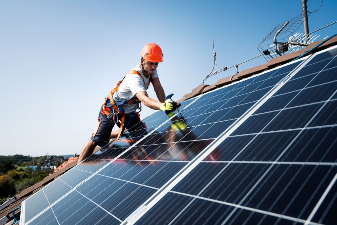
Stínící prvky jako komíny, antény či klimatizační vývody by měly být umístěny vždy na severní straně střechy.
