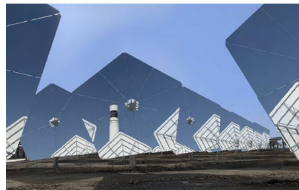
Heliostat se skládá z 11 segmentů.
