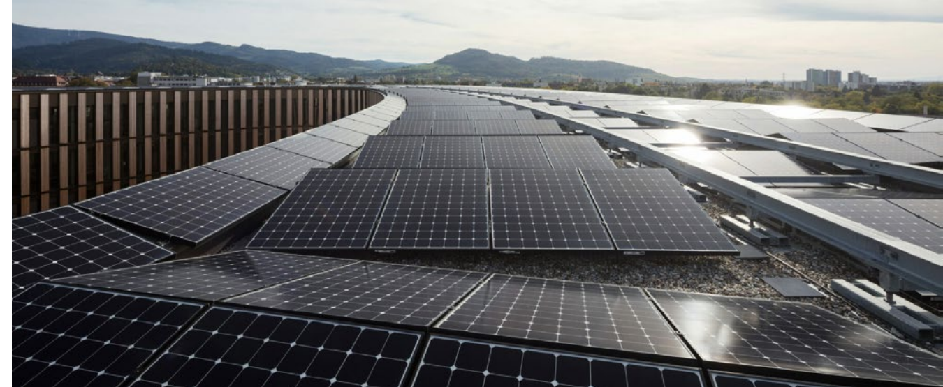
Fotovoltaické a fotovoltaicko-termické panely pokrývají 75 % povrchu střechy.
