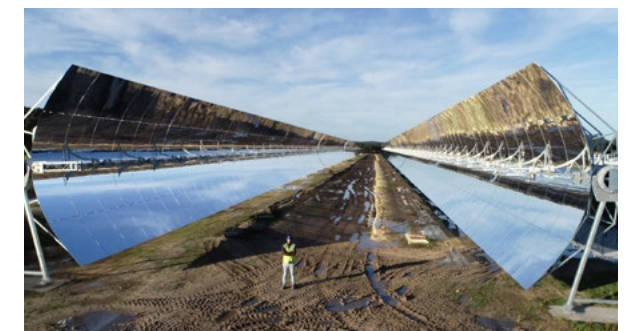
HPS2 v Évoře využívá žlabových kolektorů typu HelioTrough, které mají vysokou optickou účinnost a nižší náklady.
