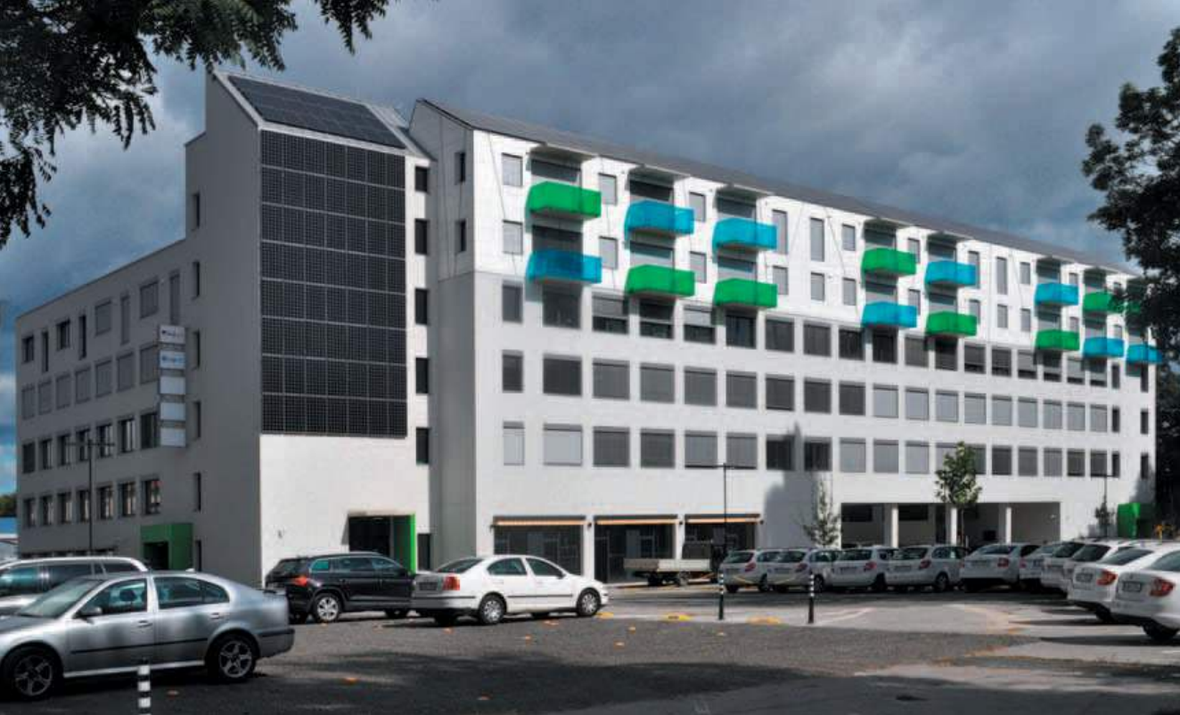
Svatopetrská, revitalizovaná jižní fasáda budovy C Foto: Josef Chybík
