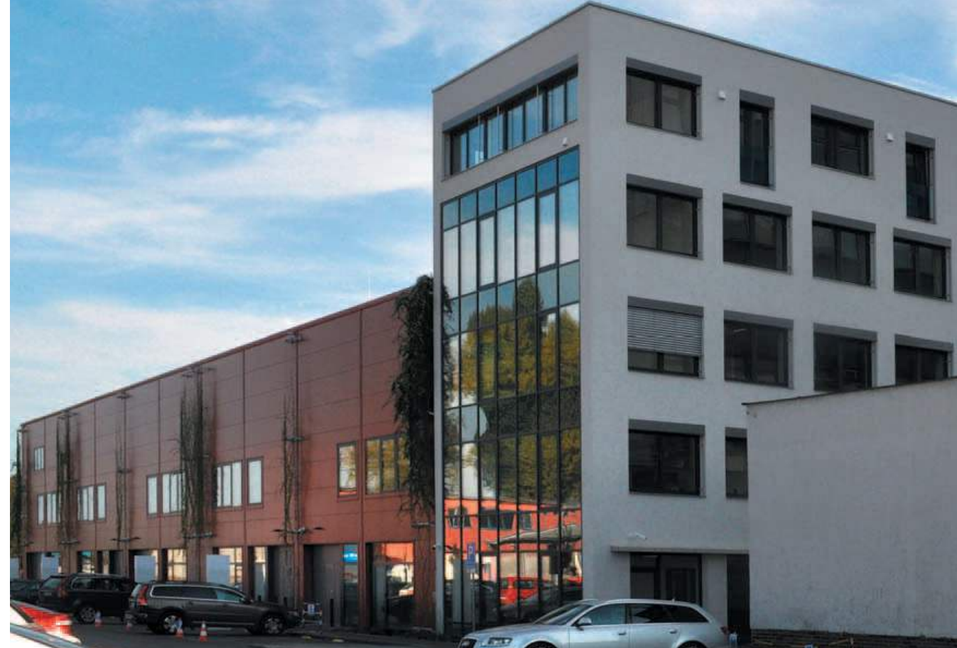
Část severně orientované fasády. Foto: Josef Chybík
