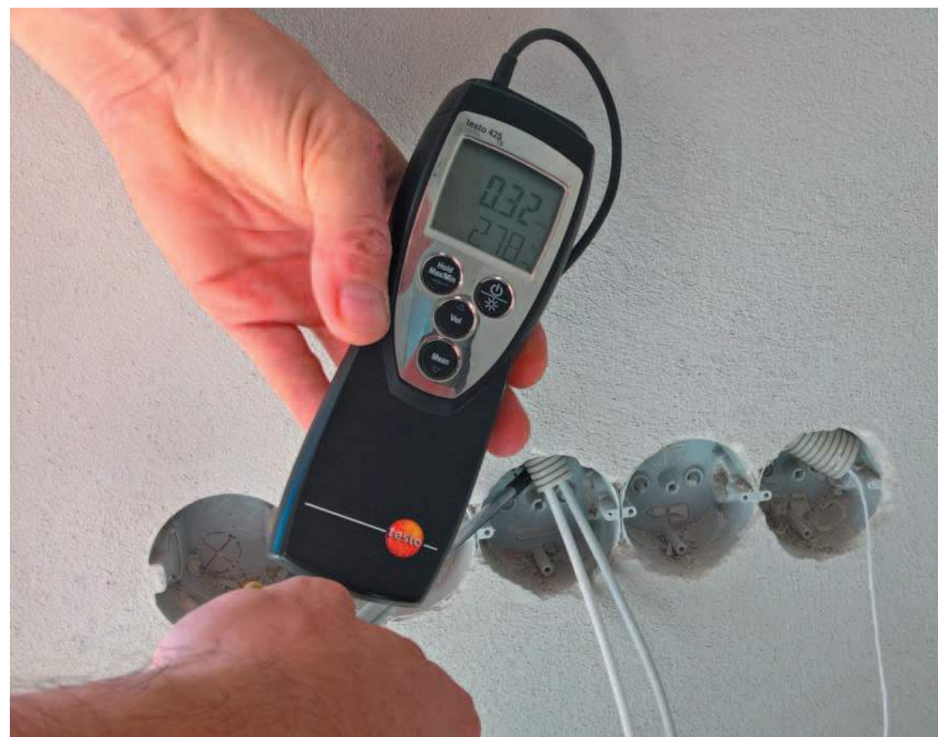
Netěsnost osazení krabice zásuvek
