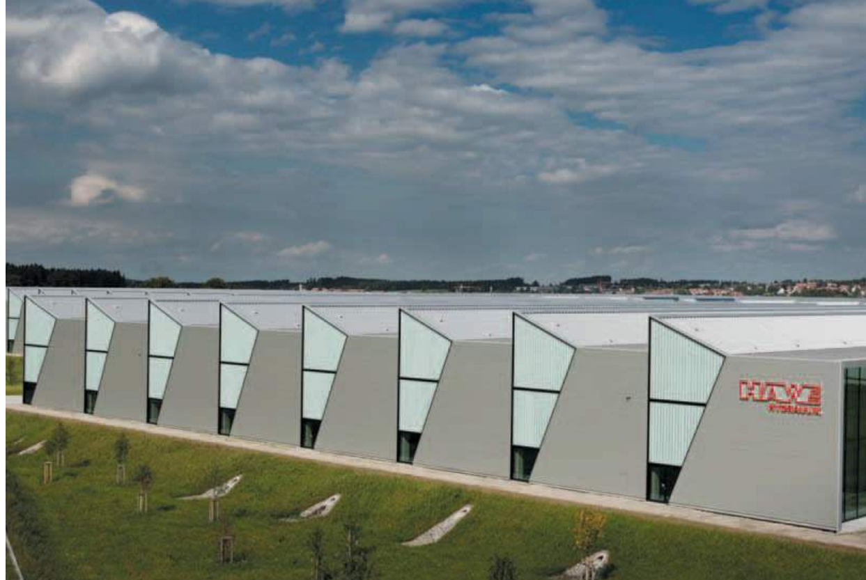
Prosklené části „zubů“ jsou orientovány na sever, zatímco na jižní straně jsou umístěny fotovoltaické panely.
