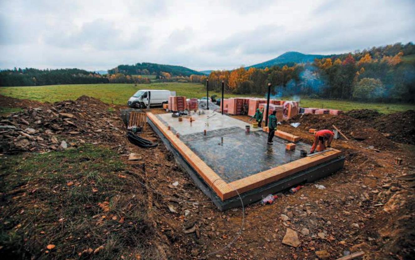
Na podzim 2019 začaly výkopové a stavební práce.
