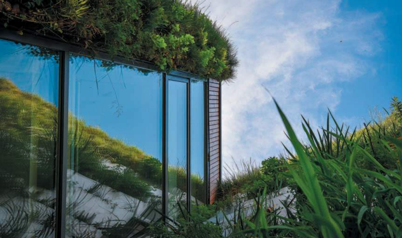
Detail fasády LIKO-Vo. Pohled zdola.
