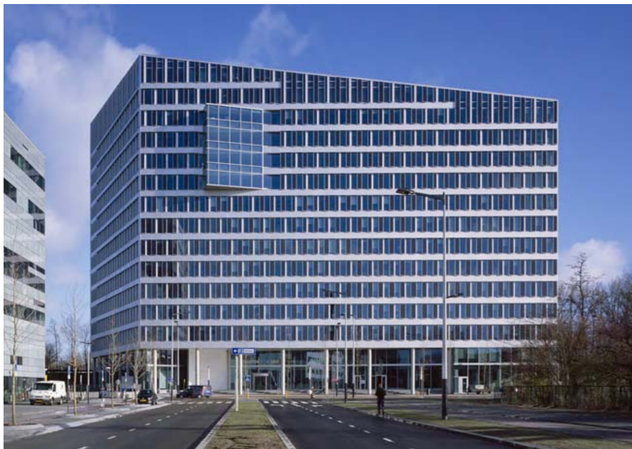
Pohled na jižní fasádu
