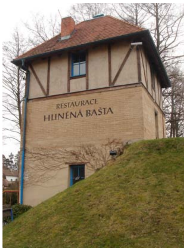
Restaurace Hliněná bašta, Průhonice, první novodobá realizace z nepálené hlíny, 1997
