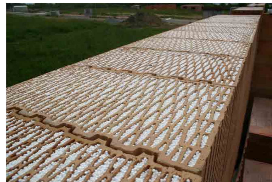
Pro téměř energeticky nulové domy lze použít cihly s integrovanou izolací HELUZ FAMILY 2in1. Izolace je uvnitř cihel, takže se nezničí. Na zdivo si lze pak vybrat z rozmanité škály fasád od běžných omítek až po luxusní fasády z různých typů obkladů.
