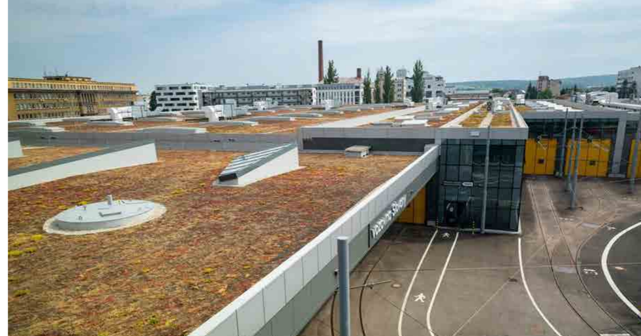
Realizace získala ocenění Stavba roku Plzeňského kraje 2023 a Adaptterra Award 2023 .
