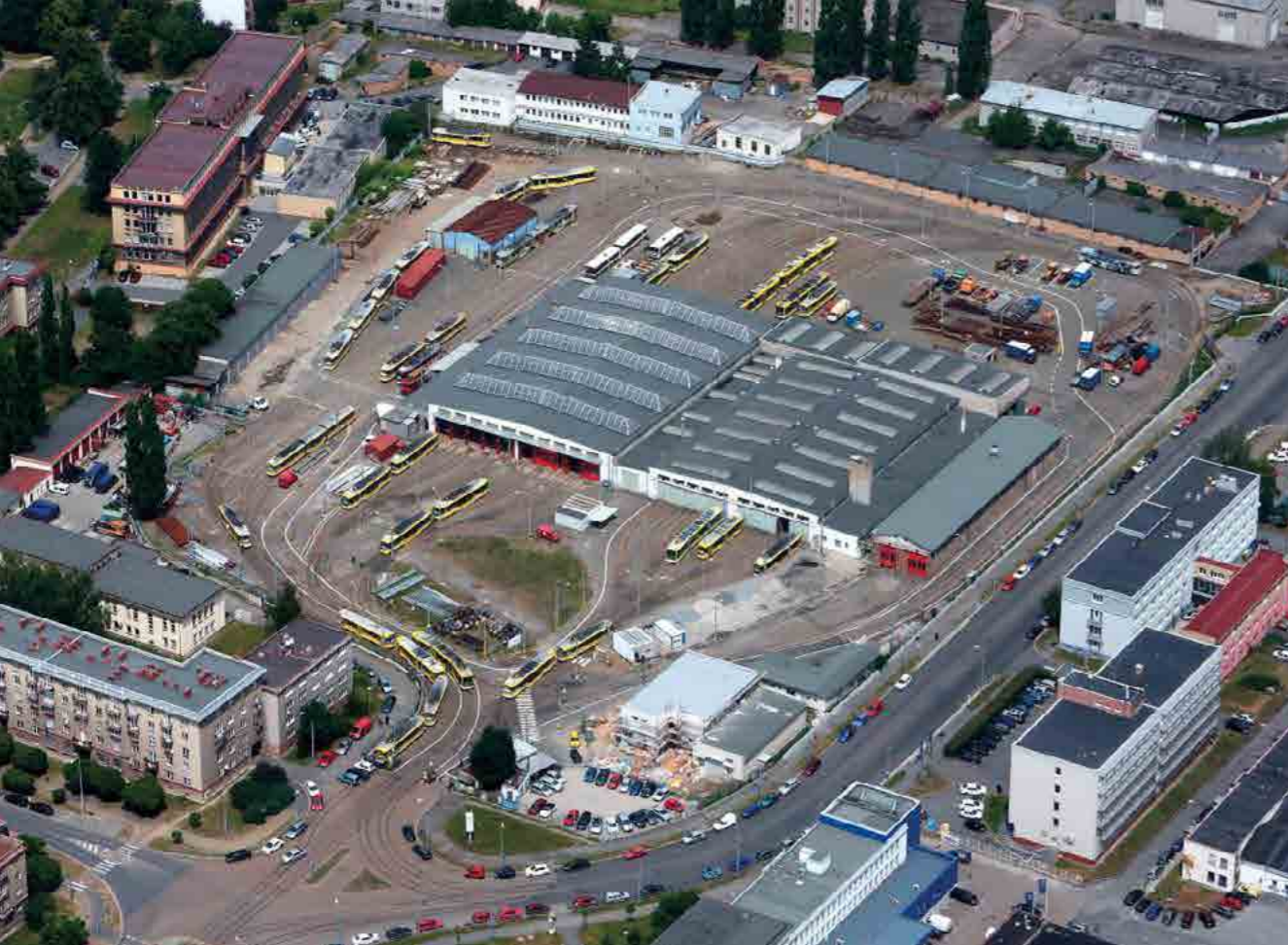
Původní stav vozovny Slovany.
