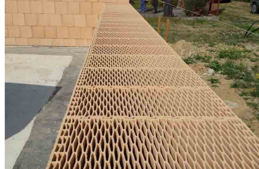
Cihelný stěp tepelněizolačních cihel HELUZ FAMILY má pevnost jako dobrý beton a tepelnou vodivost jako dřevo. Díky moderní výrobní technologii lze cihelný stěp vytvářet tak, že cihly se hodí pro nízkoenergetické budovy bez vnějšího zateplení.
